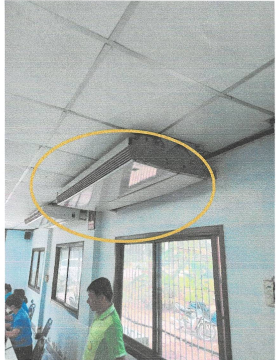
ภาพเครื่องปรับอากาศที่ติดตั้งในห้องประชุมองค์การบริหารส่วนตำบลปากท่อ ตำบลวันดาว อำเภอปากท่อ จังหวัดราชบุรี มีจำนวน ๓ เครื่อง และเสียเสื่อมสภาพทั้งหมด ๓ เครื่อง
